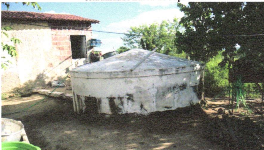
Figura 4.25 – Cisterna individual utilizada para o armazenamento de águas meteóricas na comunidade Barra do Japi
